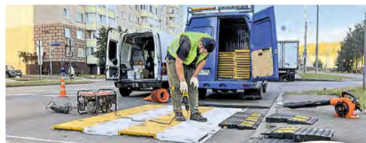
В ПМГП появится новый безопасный переход
