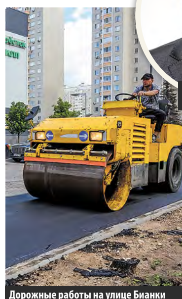
Дорожные работы на улице Бианки
